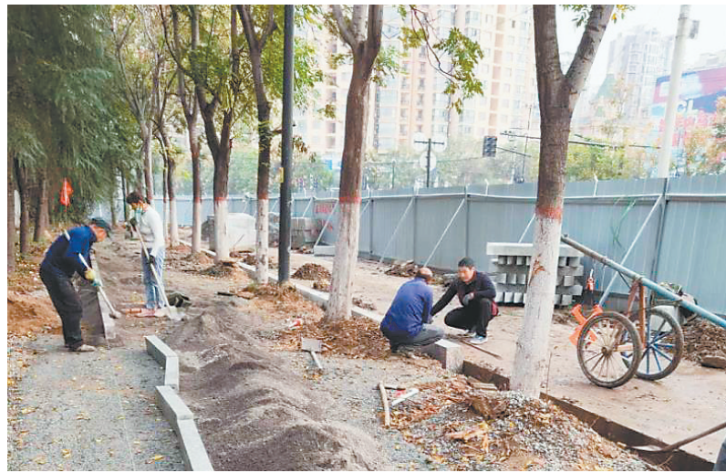
施工人员正在改造人行道。
